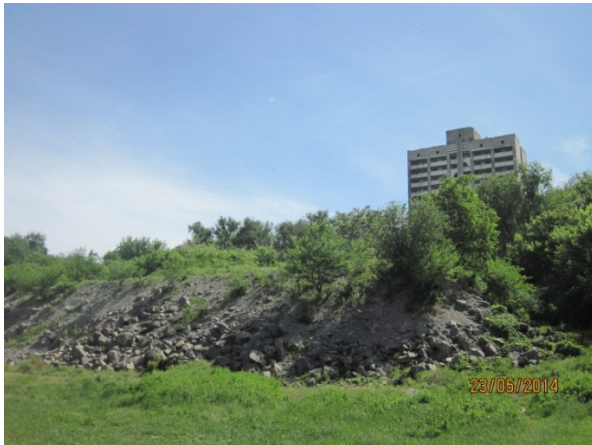
Рис. 1. Современные оползнеопасные участки г. Днепропетровска. а) Рыбальская балка, отселенный дом вследствие подвижек склона и укрепительный контрбанкет перед ним, май, 2014 год; б - балка Евпаторийская, май 2014 года
