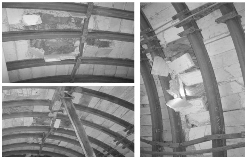
Рис.1. Деформация межрамных затяжек
